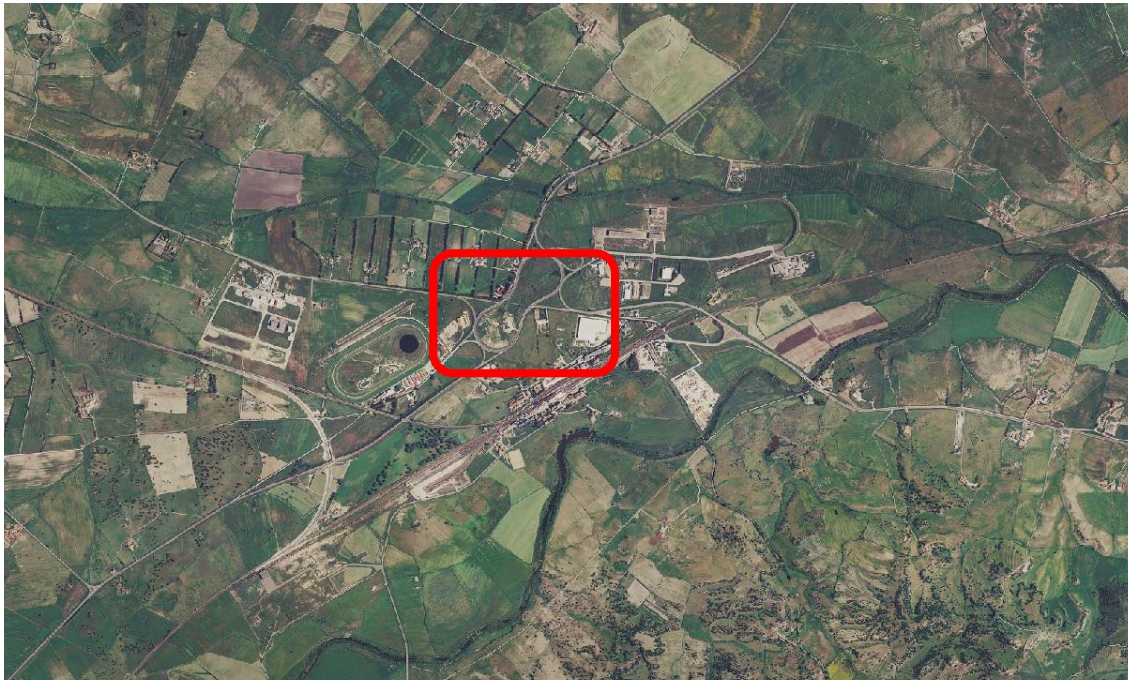
Figura 6: Foto aerea con indicazione dell'area di intervento di Ozieri (Z.I. Chilivani).
