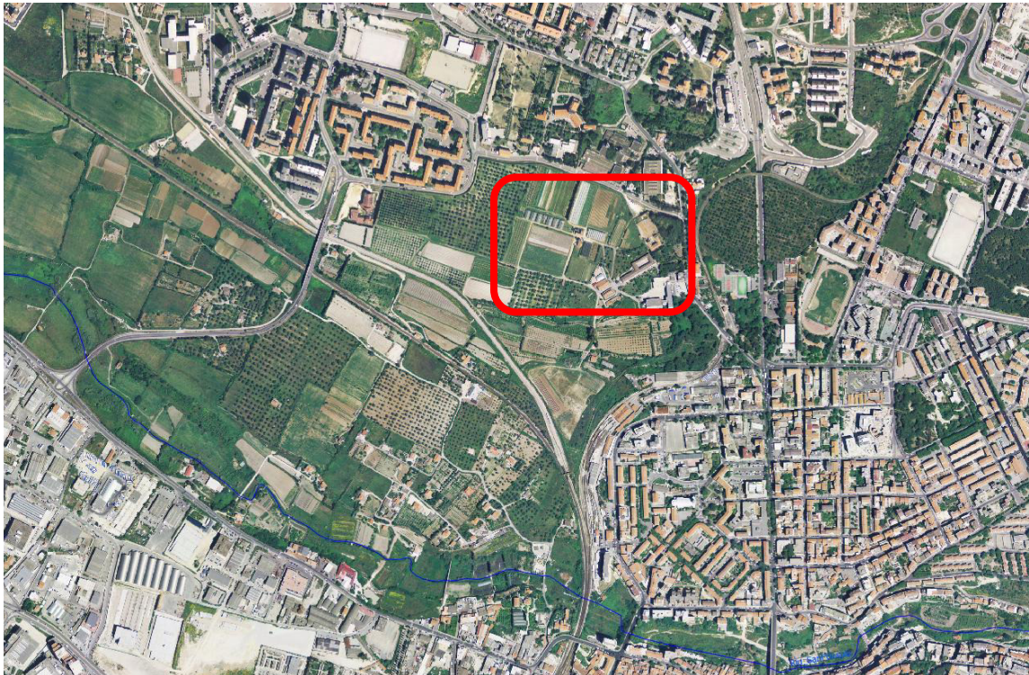
Figura 2: Foto aerea con indicazione dell'area di intervento di Sassari.
